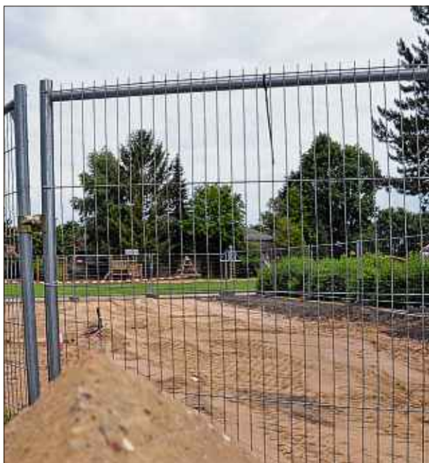
In Eldagsen wird der Boden für den Neubau des Schulgebäudes vorbereitet. MT-Foto: Oliver Plöger
