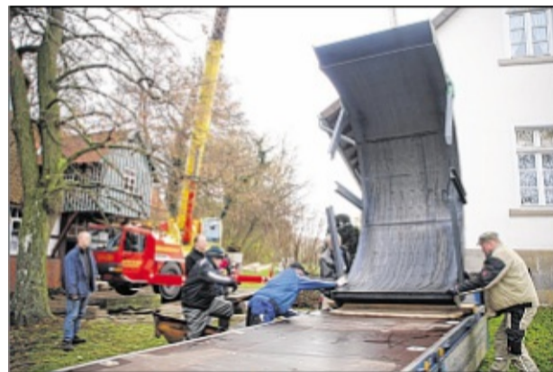
Filigranarbeit war beim Transport der neuen Einbauteile erforderlich.
