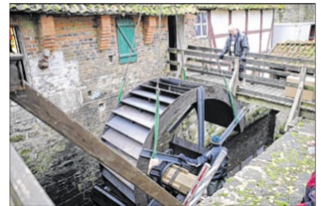
Im letzten Arbeitsgang wurden die beiden Teile des Mühlrades zusammengefügt.
