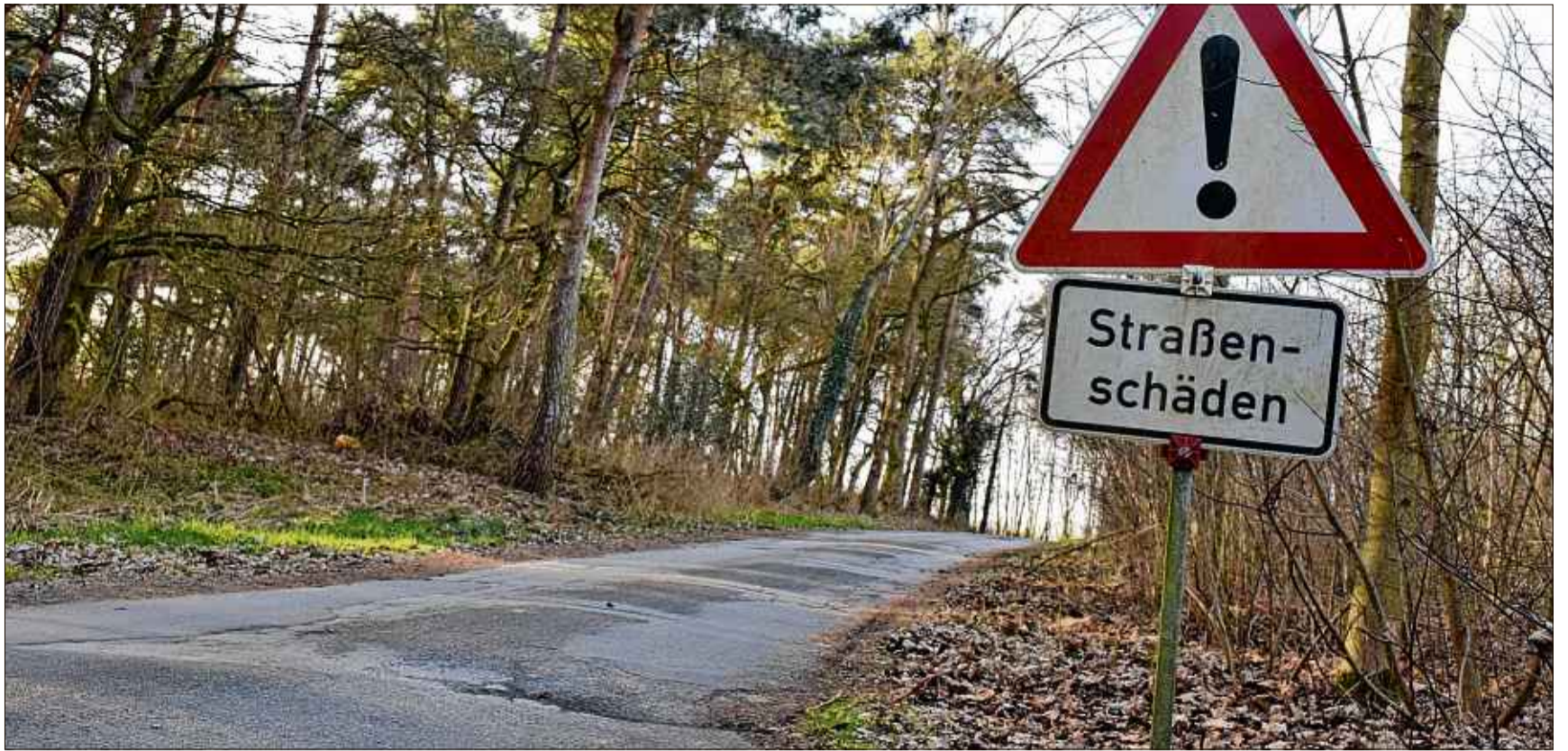
Die Straße Elmenhorst/Ecke Zur Borg in Döhren ist ein Beispiel für eine Straße mit bituminöser Decke, die möglicherweise in Zukunft geschreddert und mit einer wassergebundenen Decke versehen wird. MT-Foto: Claudia Hyna
