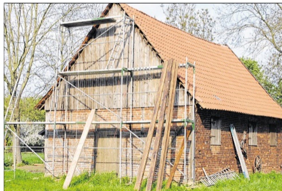
Eingerüstet: Der Verein „Dat Schönenvertel“ hat sich zum Ziel gesetzt, „Putzers Scheune“ zu sanieren. Foto: Westermann
